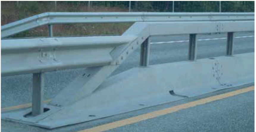
Midtdeler; tosidig overgang VG-W rekkverk
