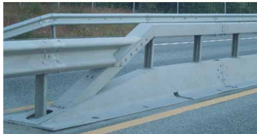
Midtdeler; tosidig overgang VG-W rekkverk
