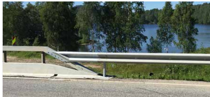
Vegkant; Ensidig overgang VG-W rekkverk
